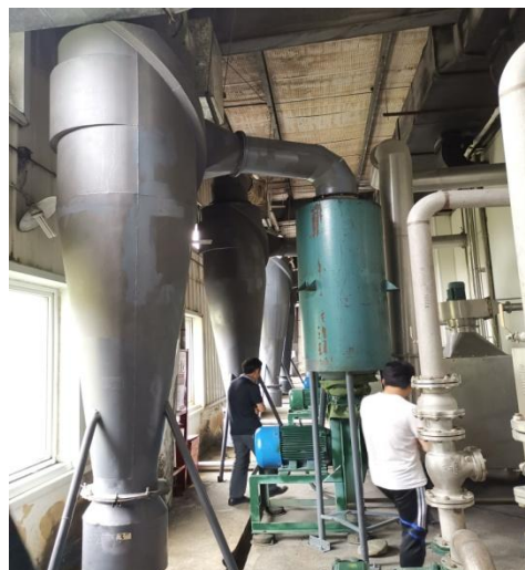
固体制剂车间旋风除尘器
