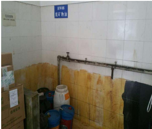
危废暂存间——废矿物油
